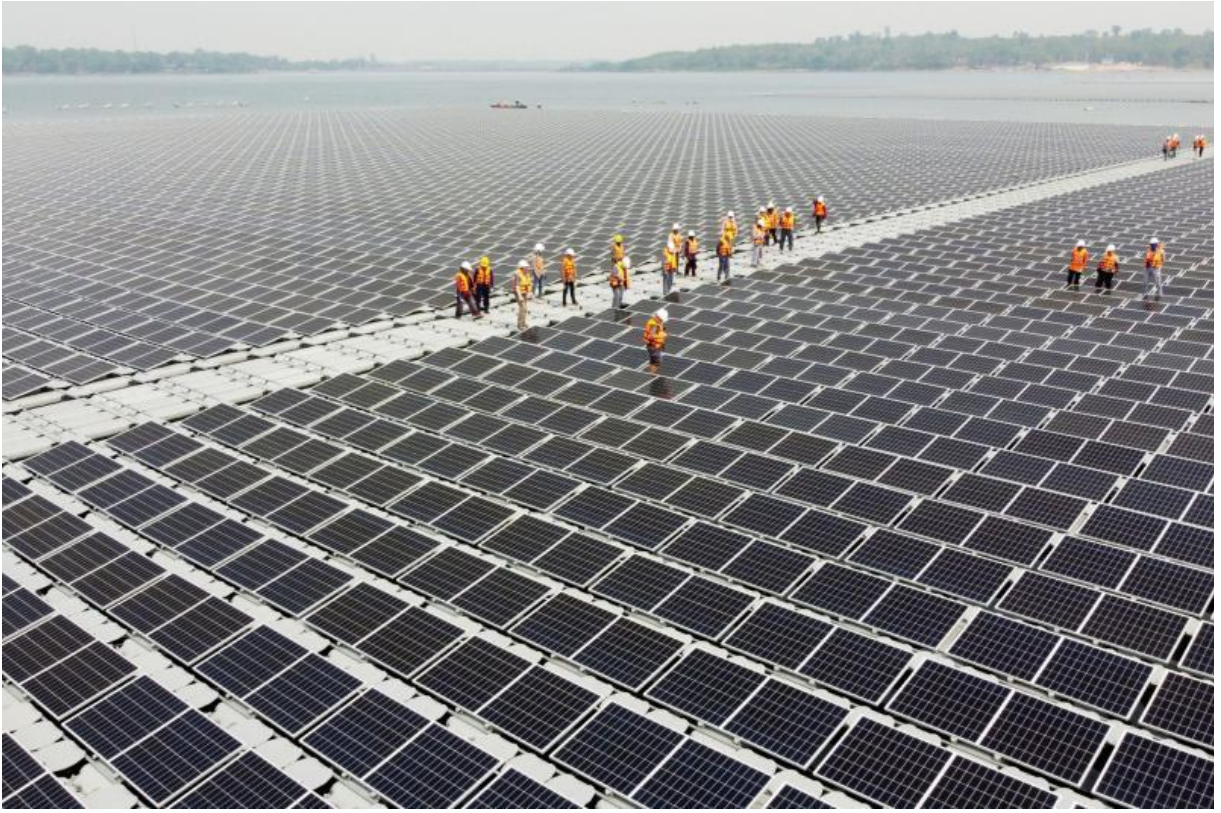
Tayland'daki Sirindhorn Barajı üzerine kurulu yüzen güneş enerjisi santrali. UEA'nın verilerine göre 2022'de dünya üretilen elektriğin yüzde 3,6'sı güneş enerjisinden elde edildi (Reuters)
